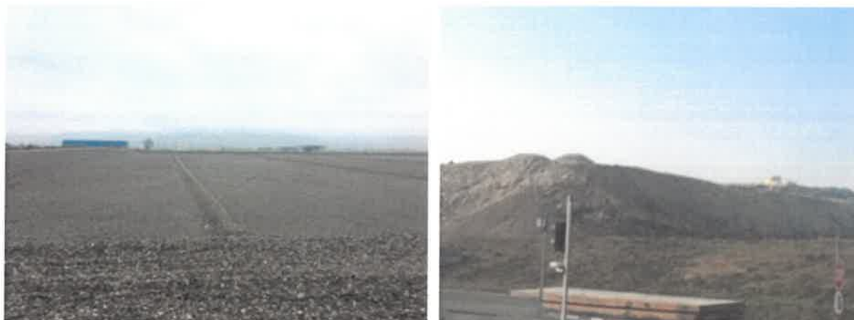
Figura 26: Celula 2 a depozitului conform de la Bacău
